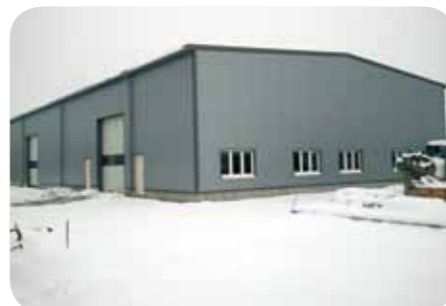
Moderne Fertigungsstätten und Lagerhallen in Deutschland – 2013 wurde unsere neue Produktions- und Lagerhalle fertiggestellt.
